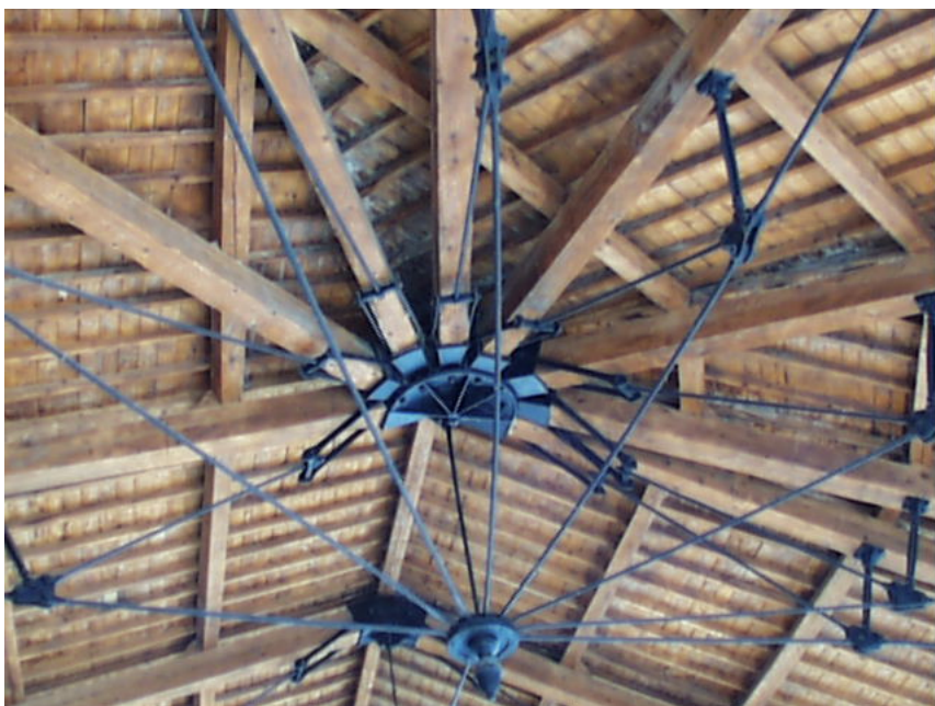
Détail de la charpente métallique.
