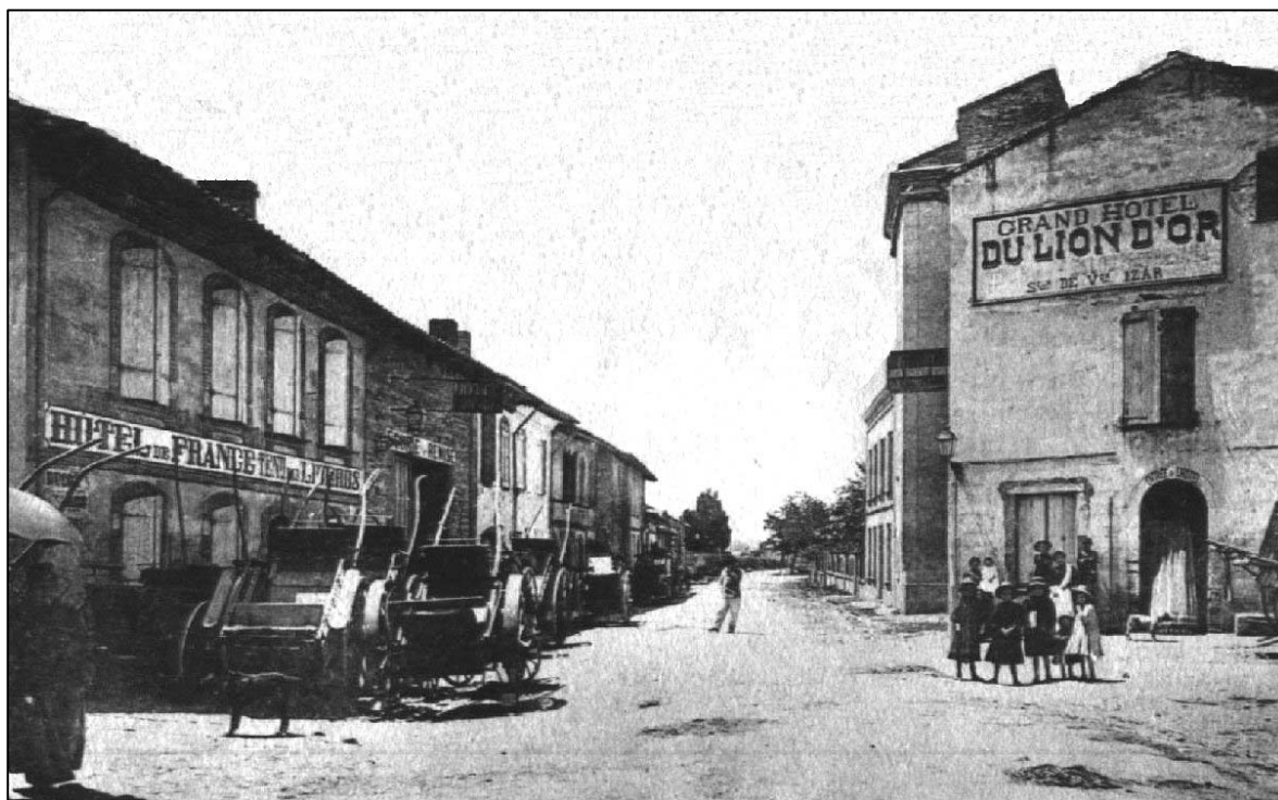
L'Hôtel du Lion d'or à droite et son pigeonnier monumental à toit de mulet à pente brisée. On devine, à la base du toit, une corniche de briques en saillie.
